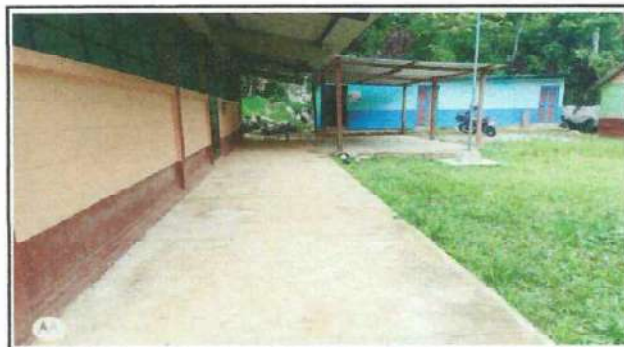
Foto 4: Colocación de entortado y piso cerámico en corredor, patio y estructura y techo de patio.
