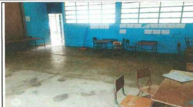
Foto 2: Colocación de piso cerámico aula 1.
