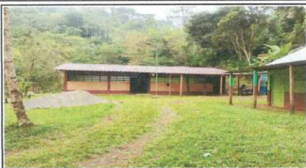
Foto1: Pintada de pared, techo y lijada y pintada de puertas de la escuela.
