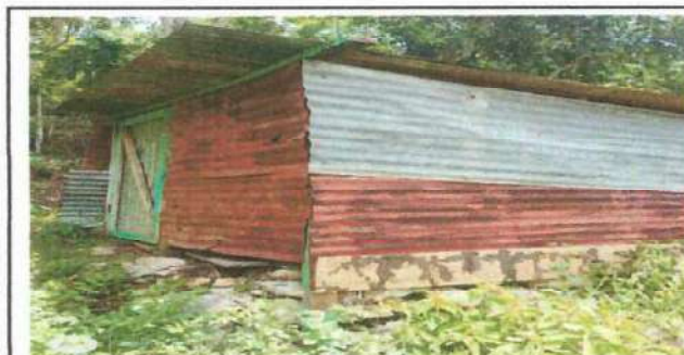
Foto 5: Levantamiento de pared de letrina y fabricación de dos puertas de metal.
